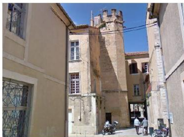
Escalier en vis - passage VIDAU
