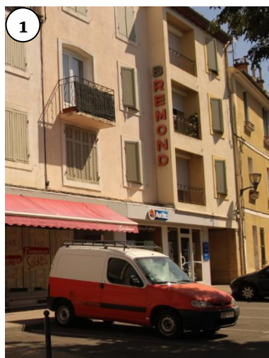
Enseigne en débord de façade, Place Joseph Guis
