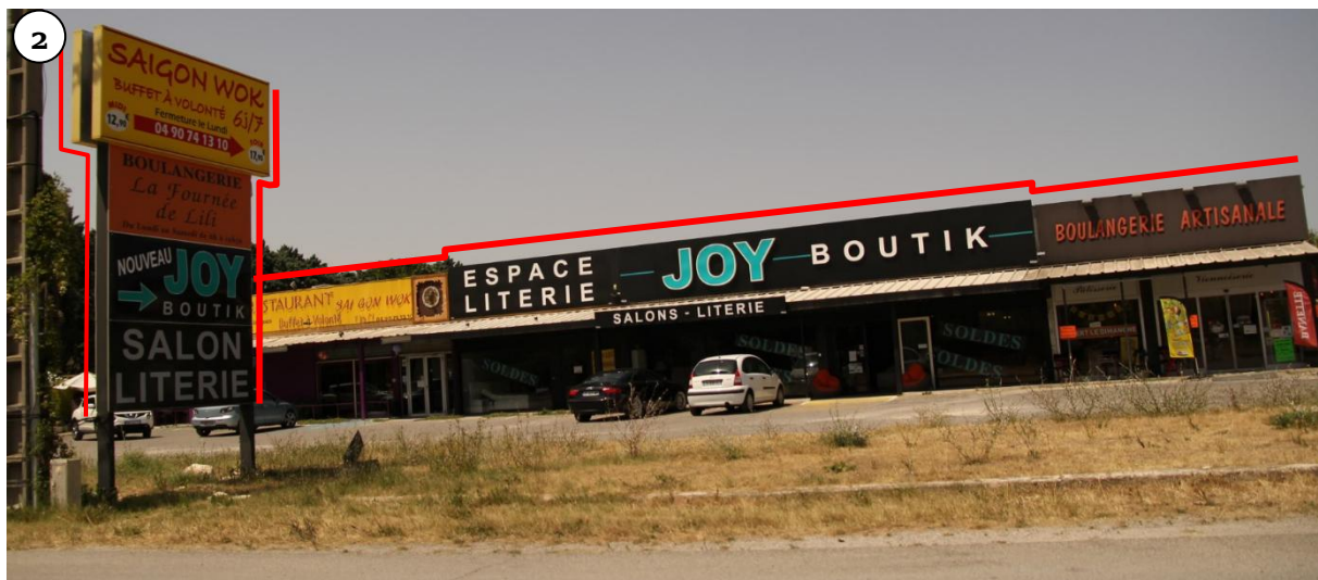
Z.A. Route de Robion, RD2
